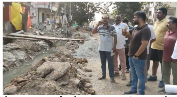
లేకుండా చర్యలు తీసుకోవాలని, నిర్మాణ సామగ్రిని రోడ్లపై కాకుండా పక్కన ఉంచాలని కాంట్రాక్టర్లకు సూచించారు. మిగిలిన పనులను యుద్ధప్రాతిపదికన పూర్తి చేయాలని అధికారులను కమిషనర్ ఆదేశించారు.
